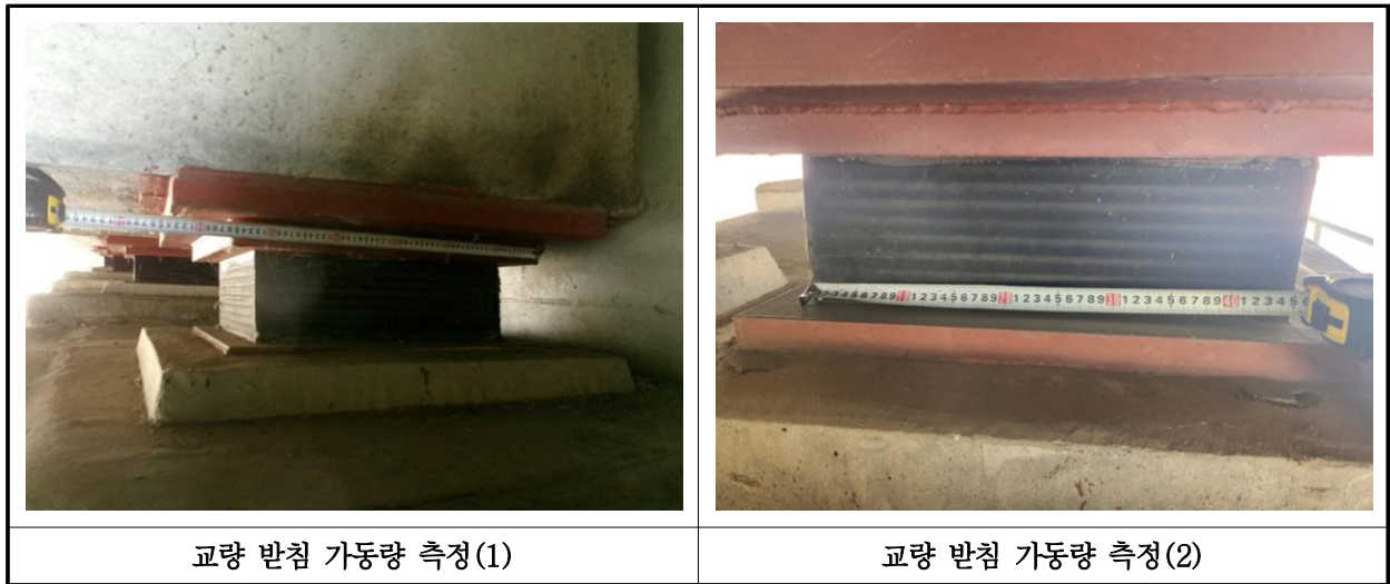
【사진 1.3.15】교량받침 이동량 측정
