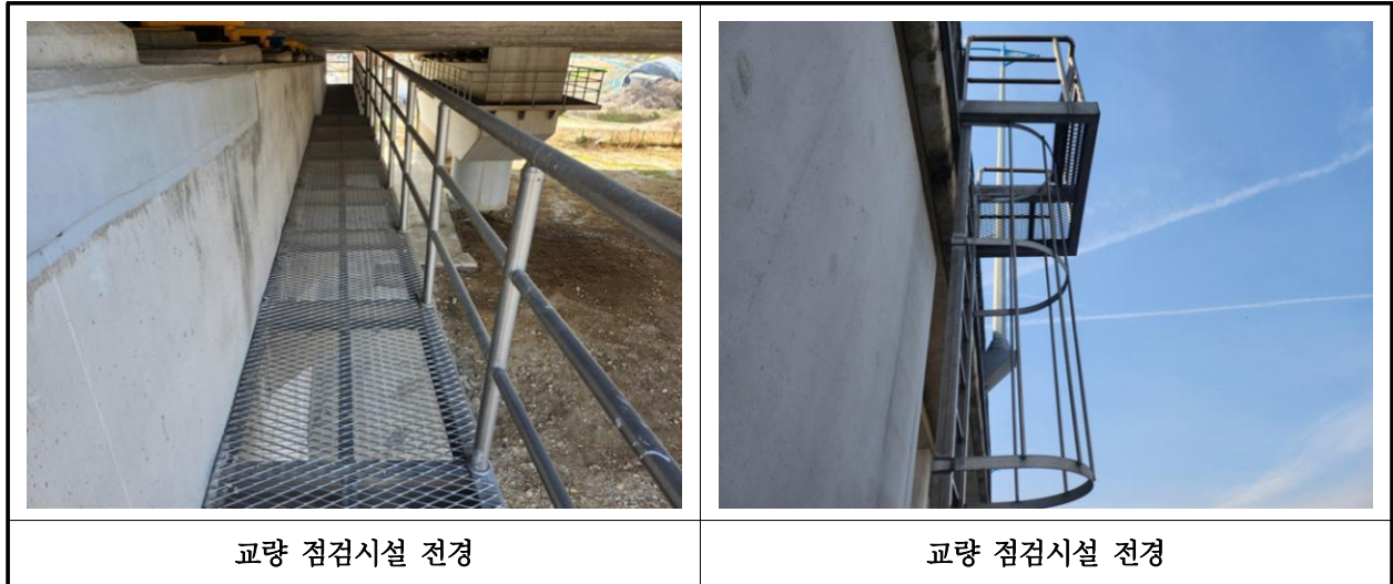
【사진 1.3.25】 교량 점검시설 전경
