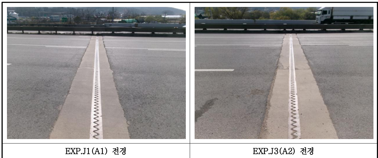
【사진 1.3.16】 신축이음장치 전경
