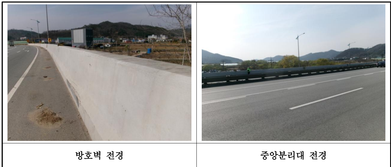
【사진 1.3.23】 난간 및 연석 전경
