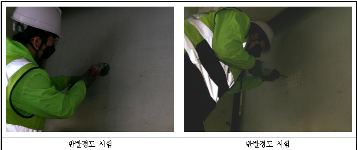
【사진 1.4.1】 반발경도시험 현장사진
