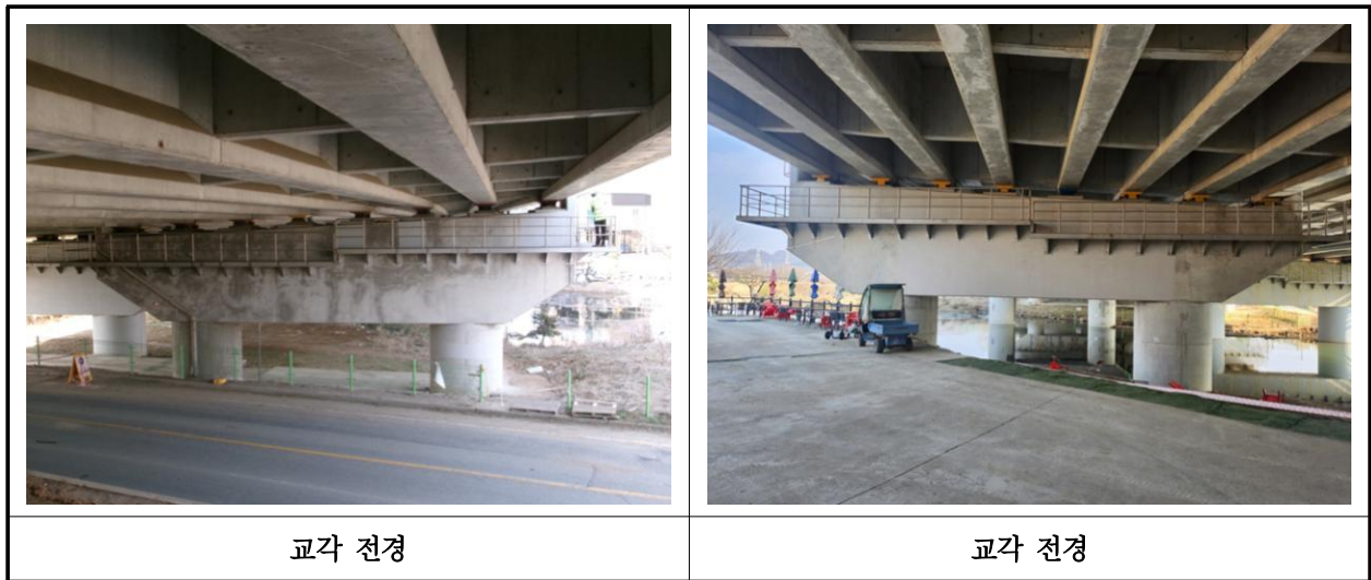
【사진 1.3.10】 교각 전경
