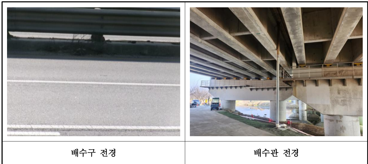
【사진 1.3.21】 배수시설 전경
